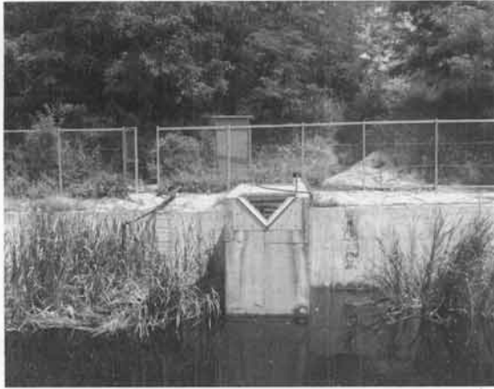
Fig. 2. V-notch weir.
